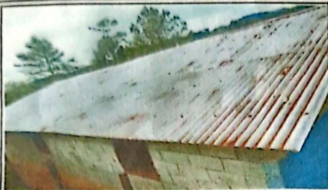
Foto1: Cambio del techado del establecimiento
